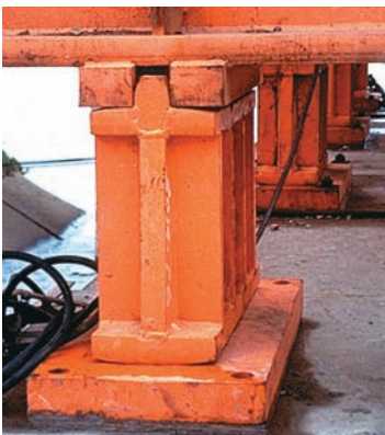
Fotografía 4.5 Se muestra la expansión del apoyo oscilatorio de un puente con plataforma de traveses. La superficie convexa del oscilador le permite al apoyo de la trabe moverse en forma horizontal.
