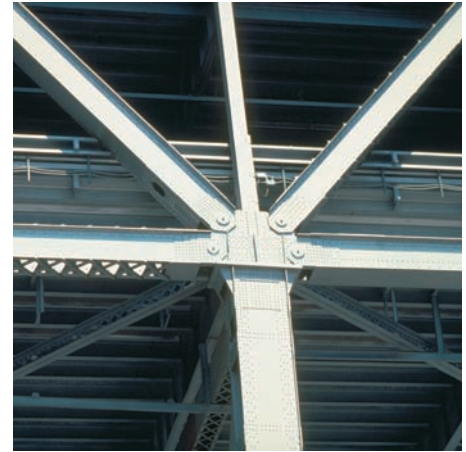
Fotografía 6.1 En la foto se muestra una conexión con juntas de pasador sobre el acceso al puente de la Bahía de San Francisco y Oakland.
