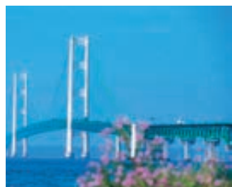
FIGURA 17.11 El puente Mackinac a través de los estrechos de Mackinac en Michigan es el tercer puente más largo de suspensión en Estados Unidos.
