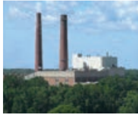
FIGURA 20.7 La planta de energía eléctrica generada por carbón de la Michigan State University provee toda la electricidad que se usa en el campus, así como también provee de calefacción en el invierno y aire acondicionado en el verano.
