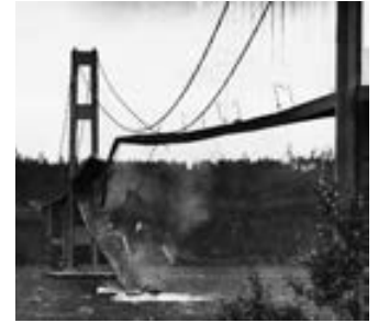
FIGURA 14.29 Colapso en la parte media del puente Tacoma Narrows, el 7 de noviembre de 1940.
